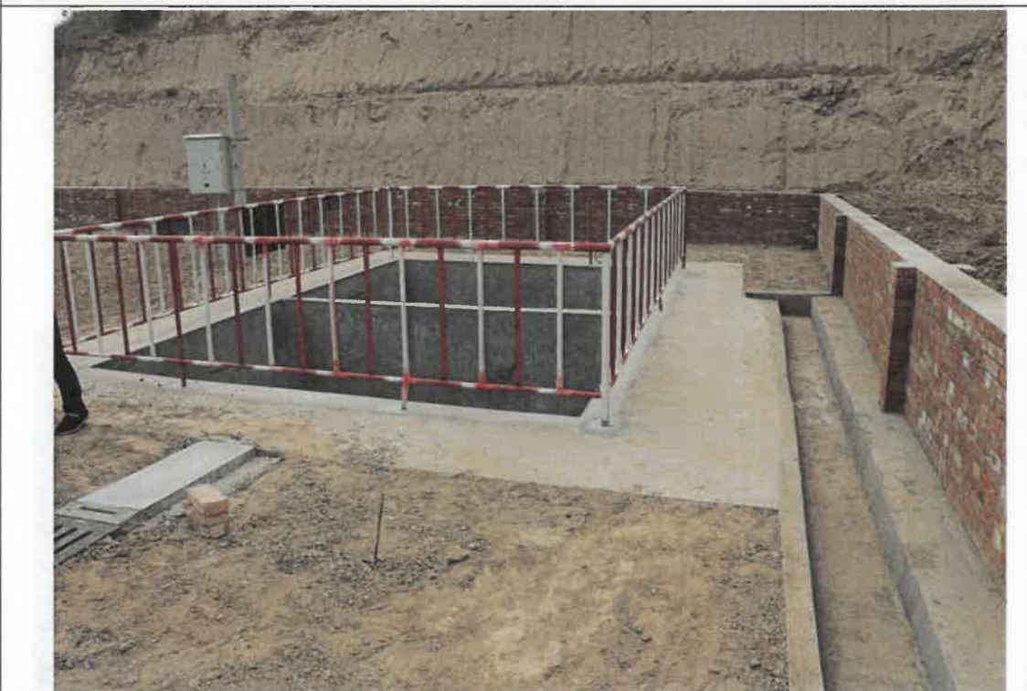
镇 44-41 井场围墙、排水沟、两池及开级削坡
