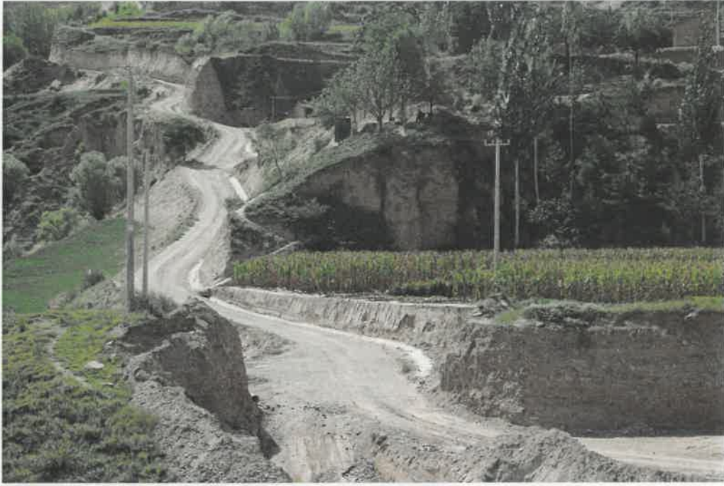
道路工程区及排水沟
