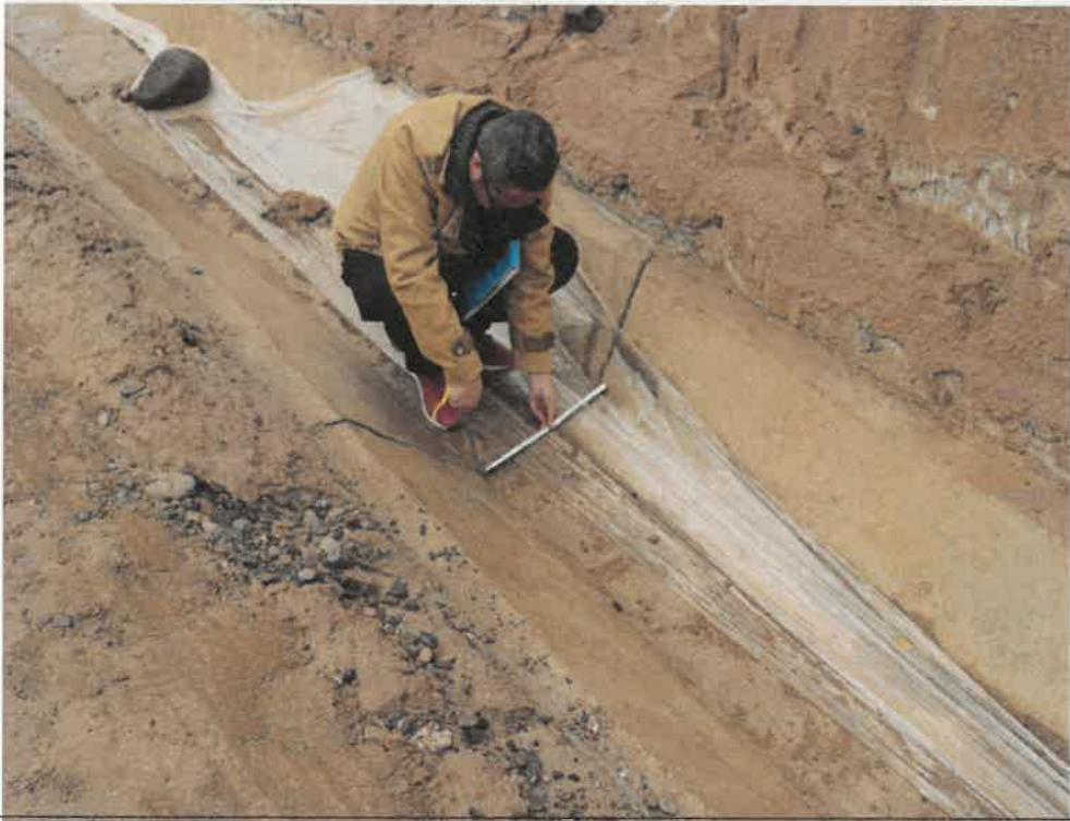
道路排水沟测量
