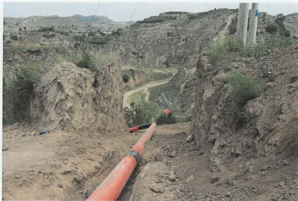
管道爬坡段施工
