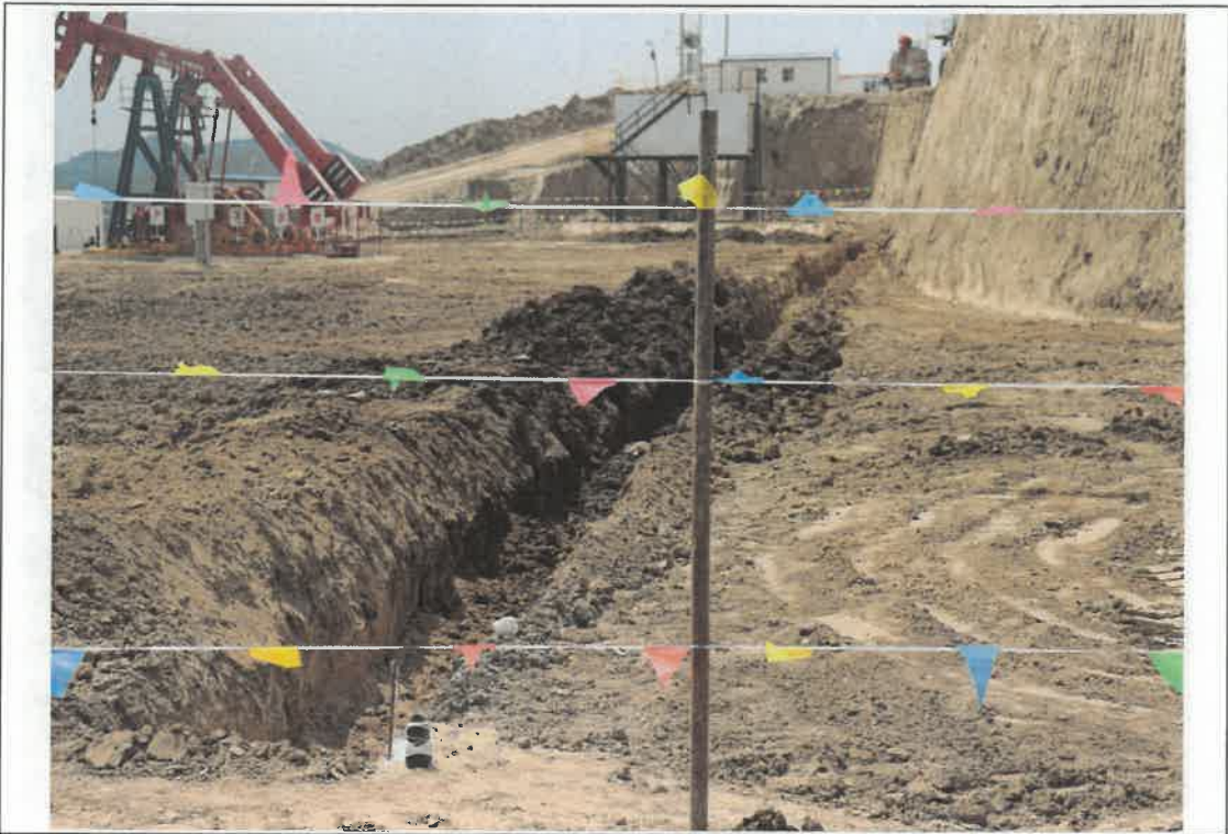
合 53 扩井场围墙施工
