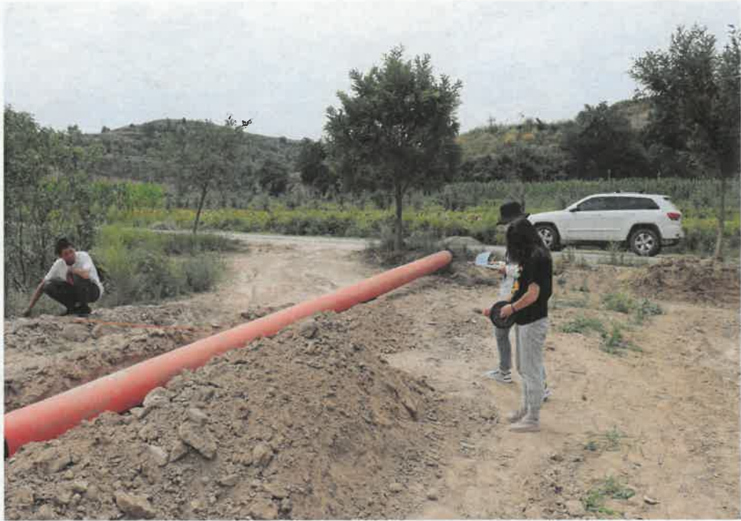
管道施工作业带测量
