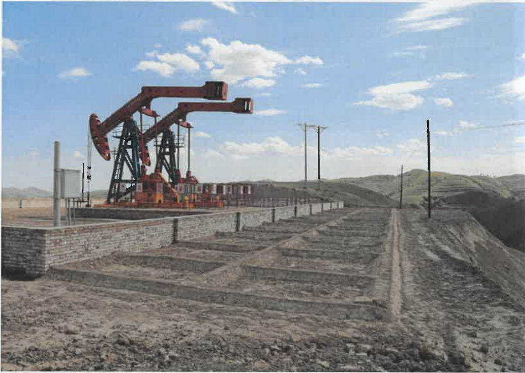
井场水平阶整地
