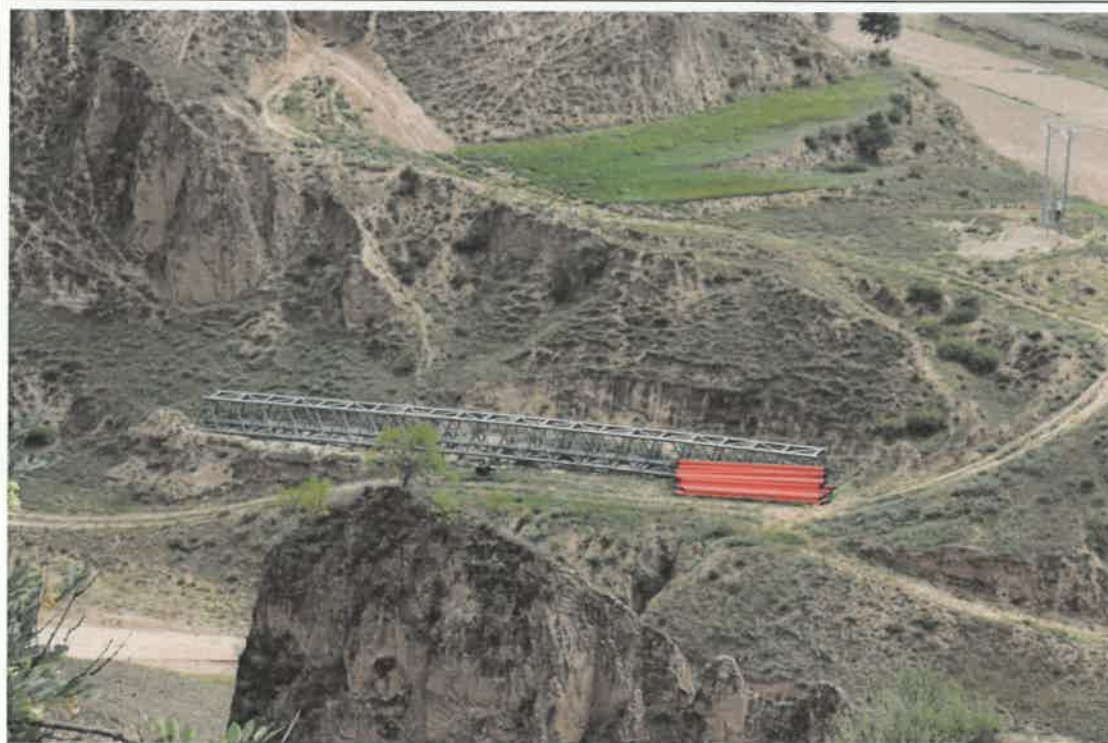
管线跨越段施工
