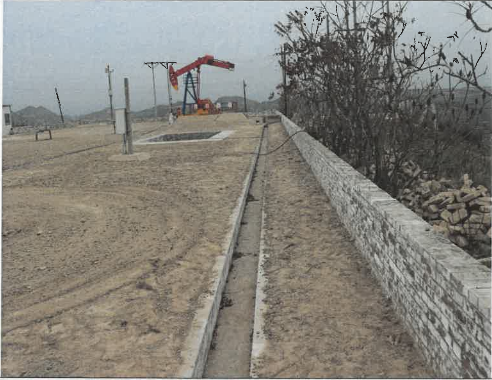
井场围墙及排水沟
