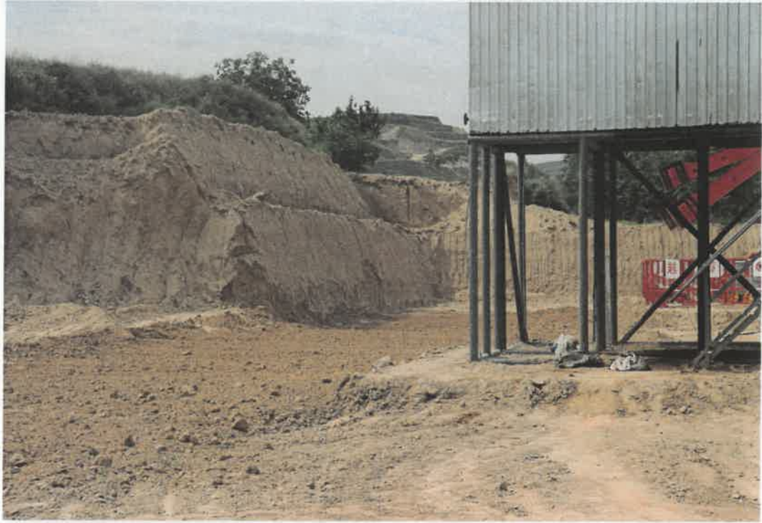
镇 185-31 井场开级削坡
