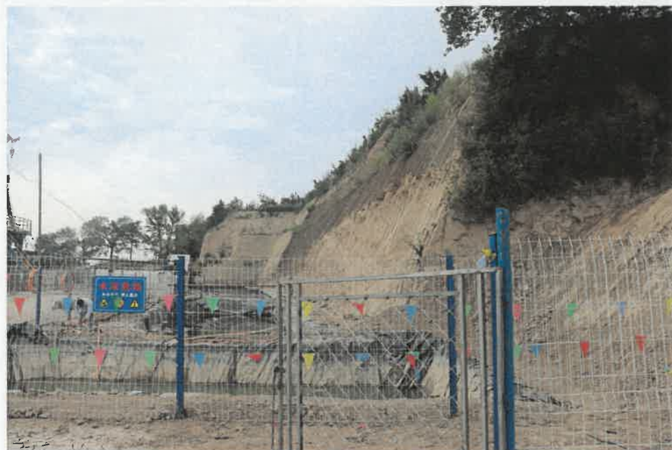
井场开级削坡及临时排蓄措施
