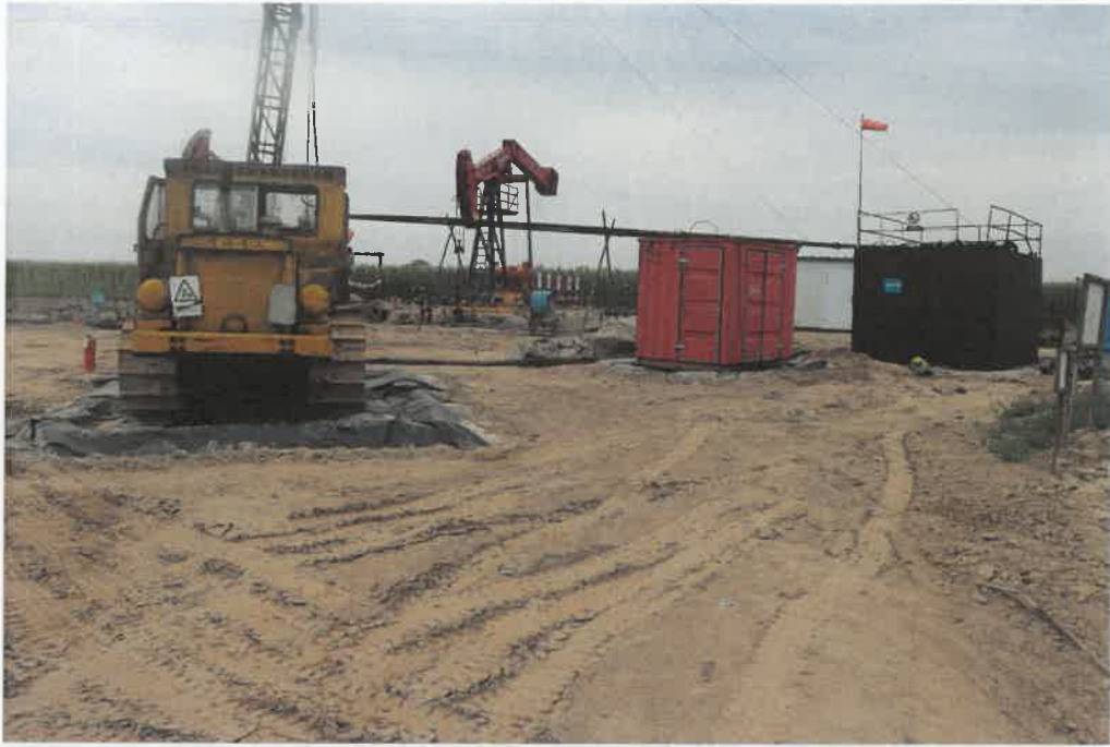
镇 413 扩扩建井场临时排水沟
