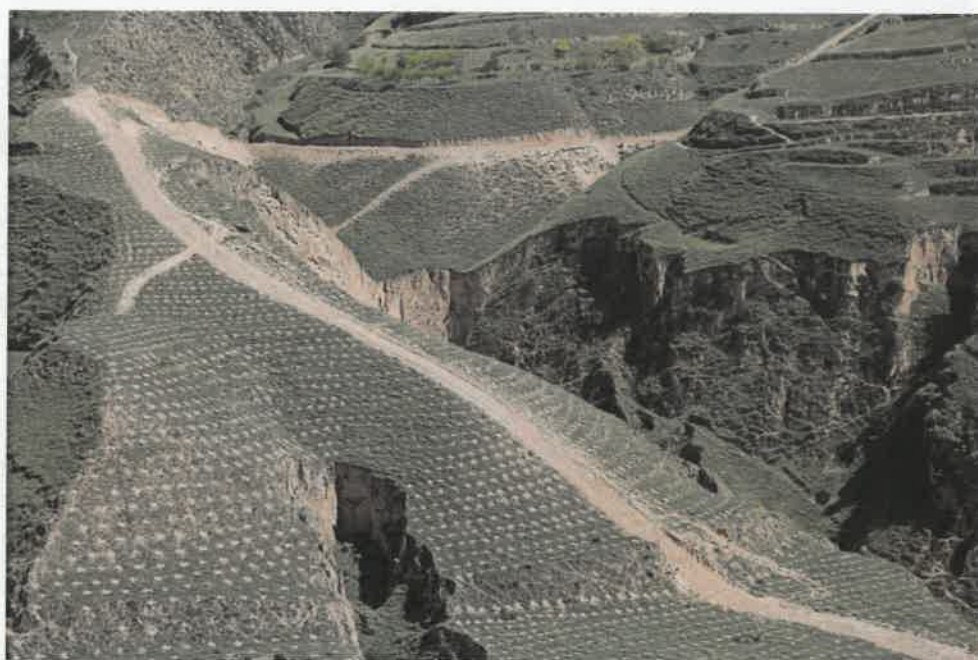
管线工程区鱼鳞坑整地
