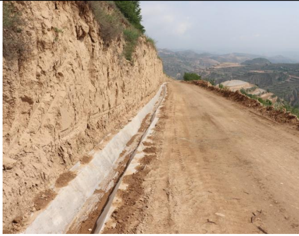
混凝土排水沟
