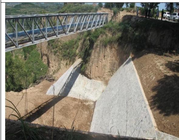
4号渡管及边坡防护（2022年9月）
