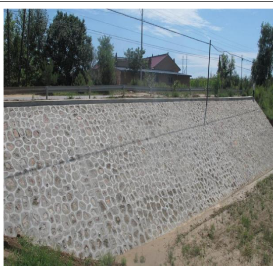
浆砌石护坡（2022年9月）
