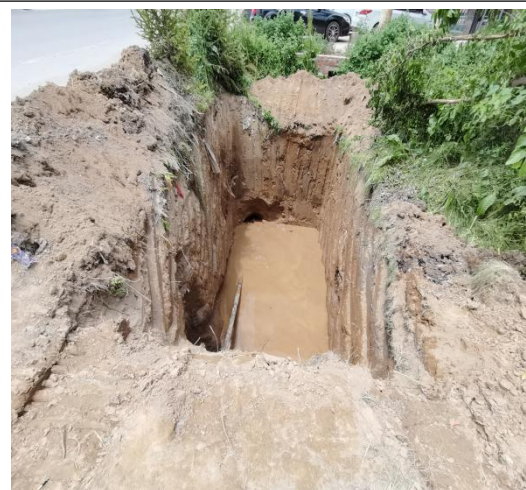
泥浆沉淀池 (2021 年 6 月)
