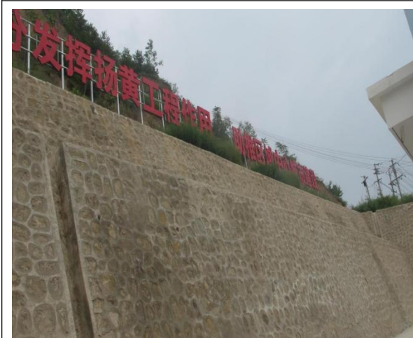
一泵站边坡防护（2022年9月）
