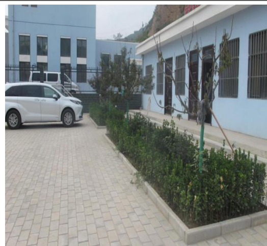
一泵站植物措施（2022年9月）
