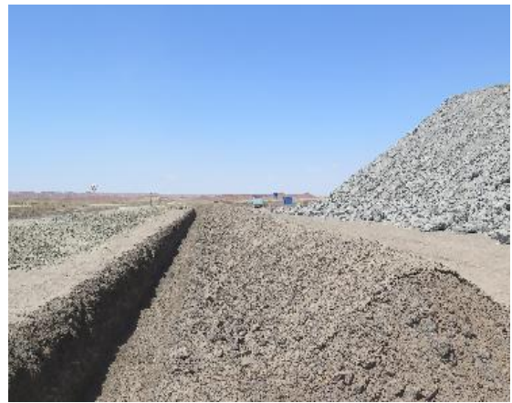
排水沟（内排土场）
