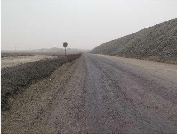
3号防洪堤（采掘区）
