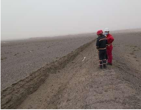
西侧排水沟（采掘区）
