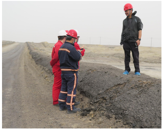
3号防洪堤（采掘区）
