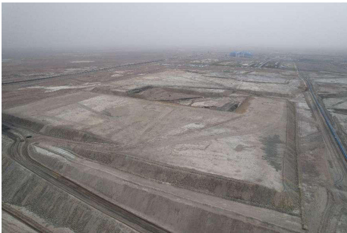
内排土场（拍摄时间：2022年5月）
