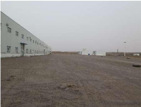
碎石压盖（工业场地）
