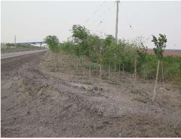
东二路绿化（进场道路）
