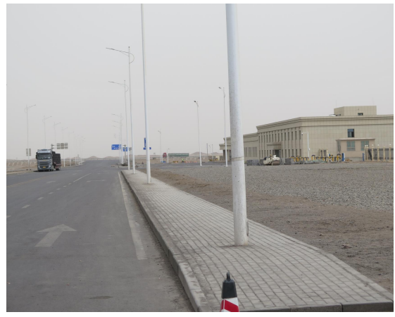
碎石压盖（进场道路）
