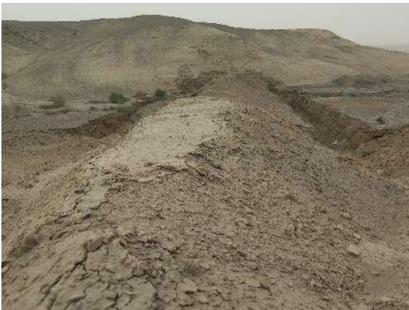
6号防洪堤（采掘区）
