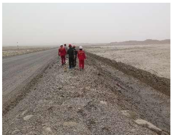
北侧排洪沟（采掘区）
