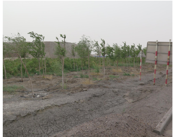
绿化灌溉系统（进场道路）
