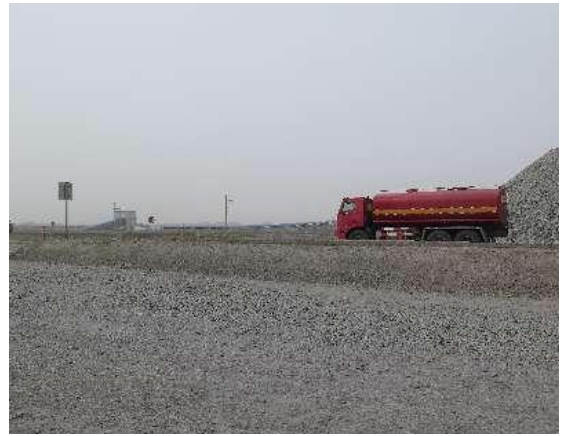
降尘洒水（工业场地）
