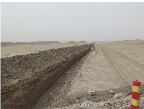
北侧排洪沟（采掘区）
