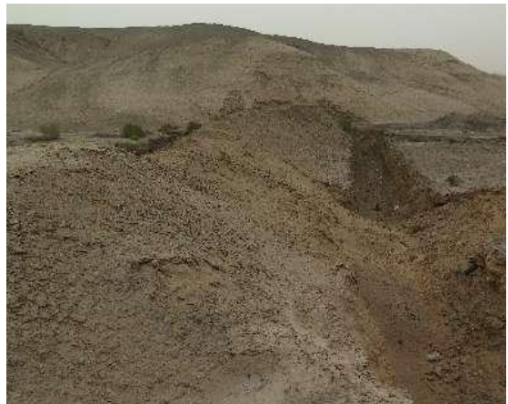
6号防洪堤（采掘区）
