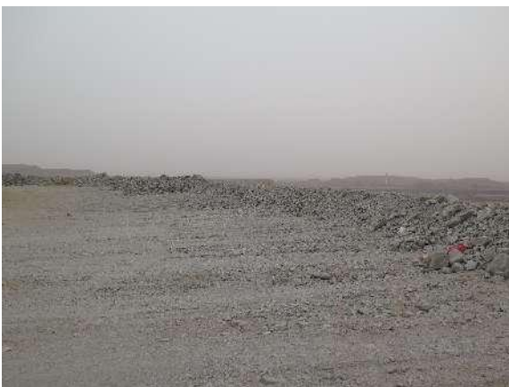
块石压盖（内排土场）
