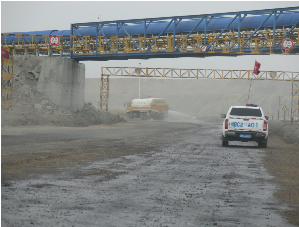
降尘洒水（进场道路）
