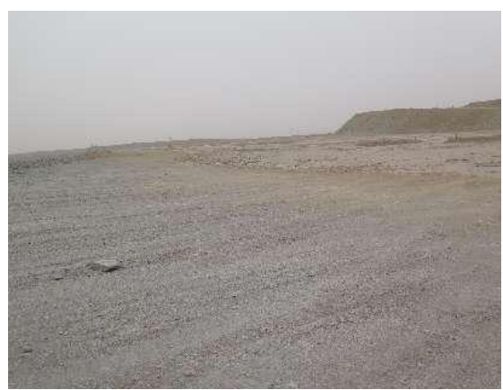
碾压结皮、块石压盖 （内排土场）
