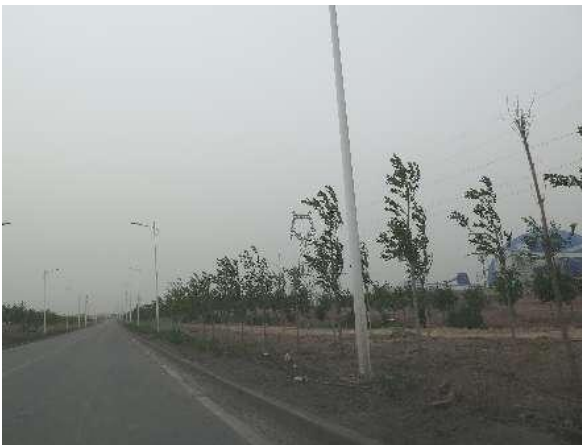
东一路绿化 （进场道路）
