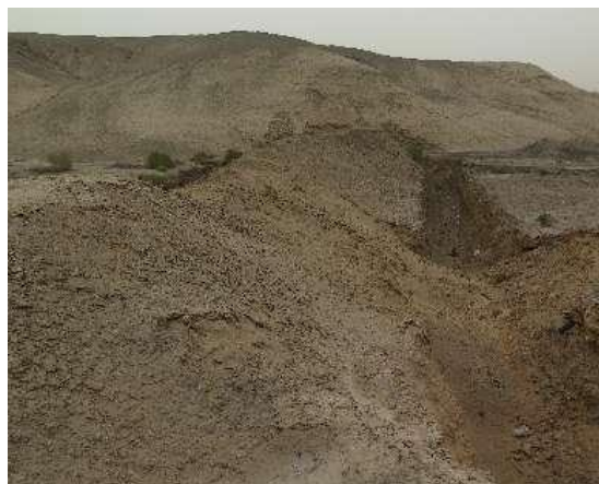
6号防洪堤（采掘区）
