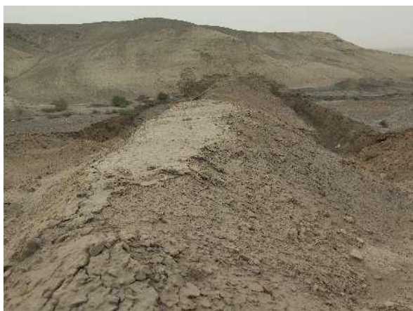
6号防洪堤（采掘区）
