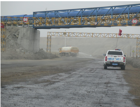
降尘洒水（进场道路）
