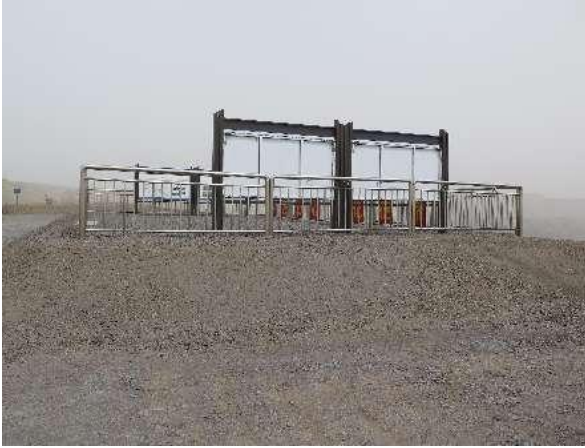
观礼台碎石压盖（工业场地）
