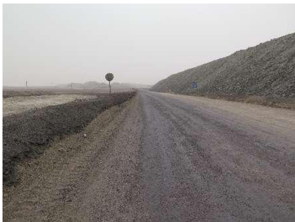
3号防洪堤（采掘区）
