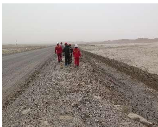
北侧排洪沟（采掘区）
