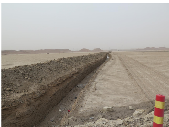
北侧排洪沟（采掘区）
