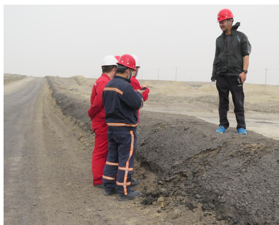
3号防洪堤（采掘区）
