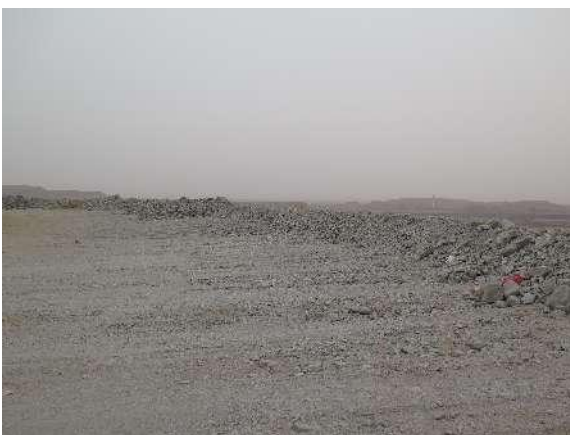
块石压盖（内排土场）
