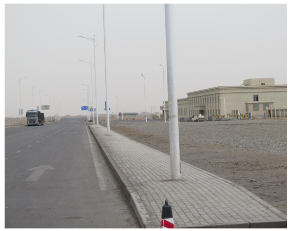
碎石压盖（进场道路）
