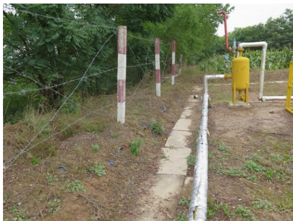
混凝土排水沟 (17P11 井场)
