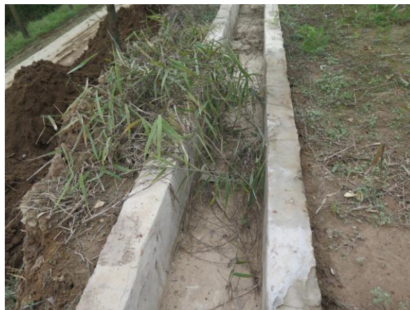
混凝土排水沟 (17P33 井场)
