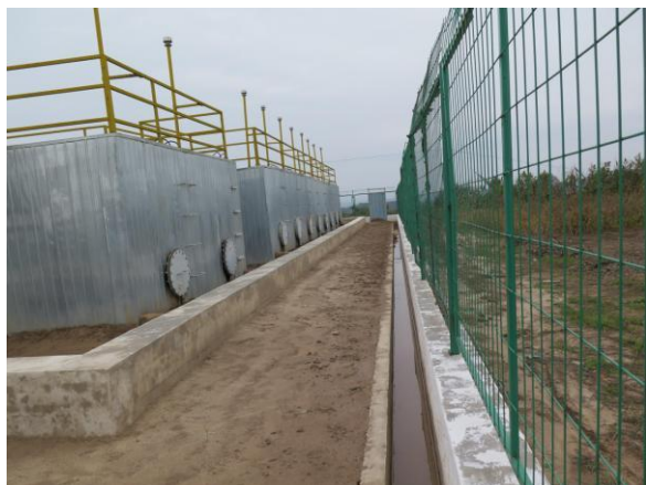
混凝土排水沟 (17P8 井场)
