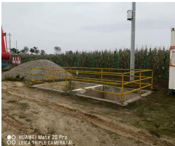
JH17P27 油井污水收集池
