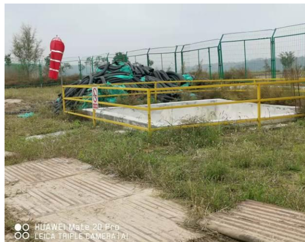
JH55P2 油井区雨水收集池
