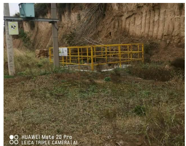
JH17P9 油井雨水收集池
