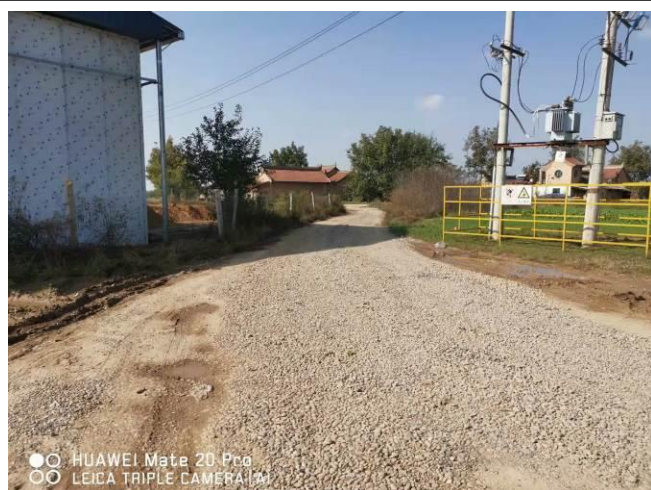
JH2P8 油井道路砾石压盖
