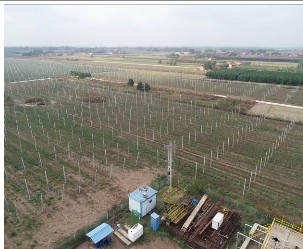
JH2P4 油井输变电线路
