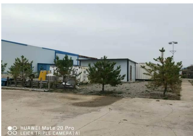
JH8 井场乔木绿化、裸露地表硬化
