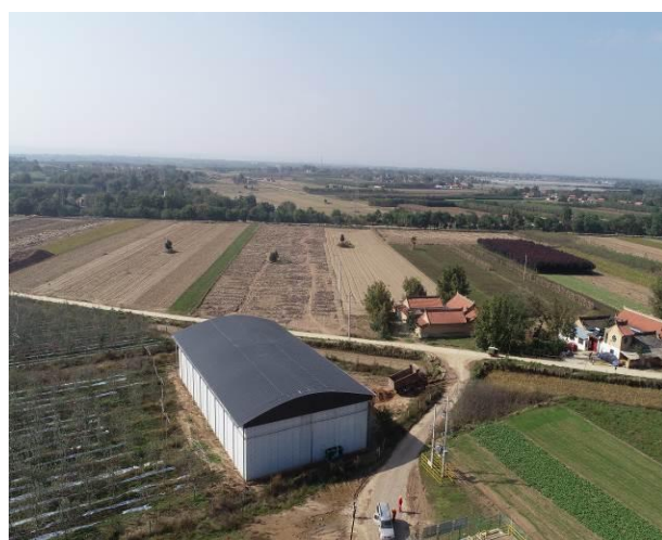
JH2P8 油井输变电线路
