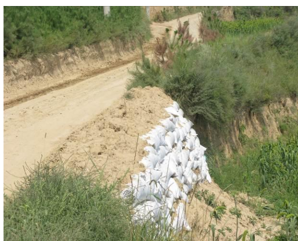
装填土袋道路护坡
