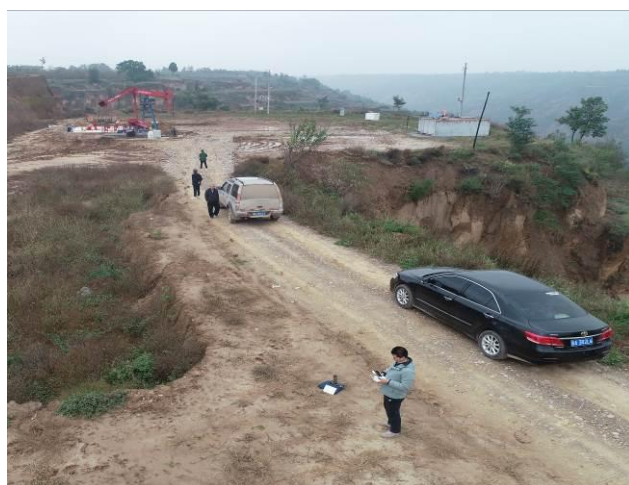
JH55P1 油井道路砾石压盖
