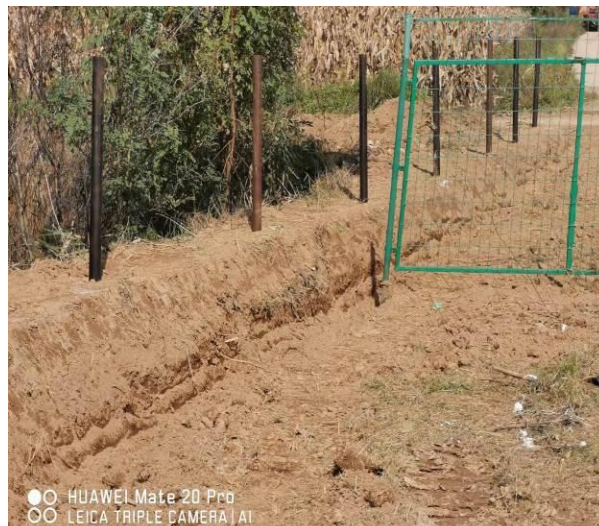
JH2P6 油井区临时排水沟
