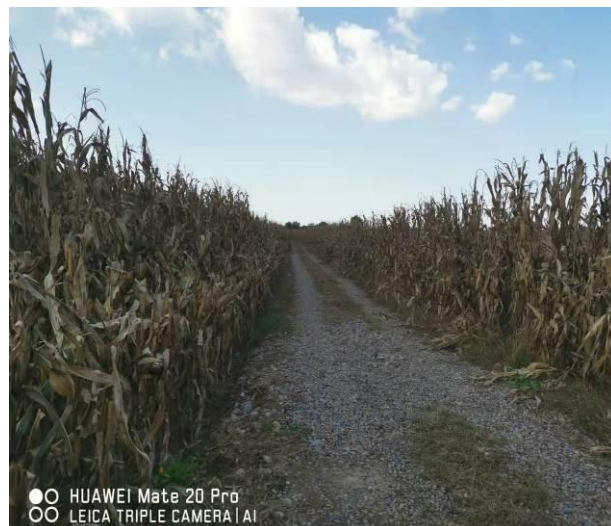
JH17P16 油井道路砾石压盖
