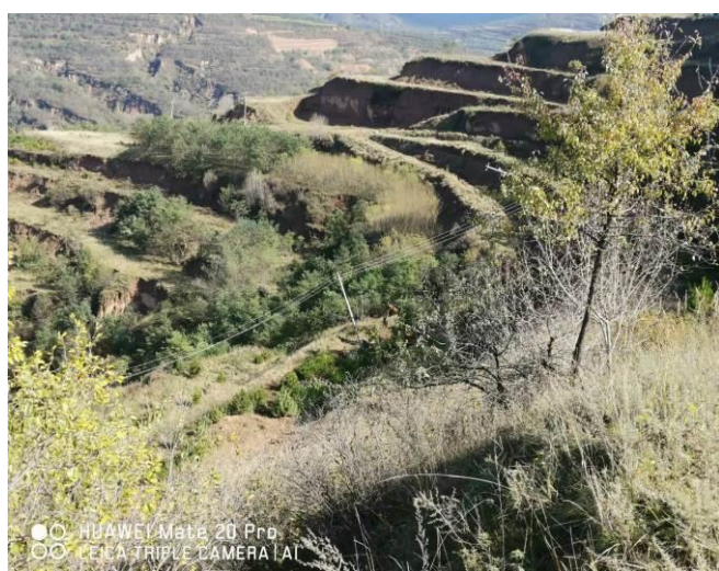
JH17P22 油井输变电线路
