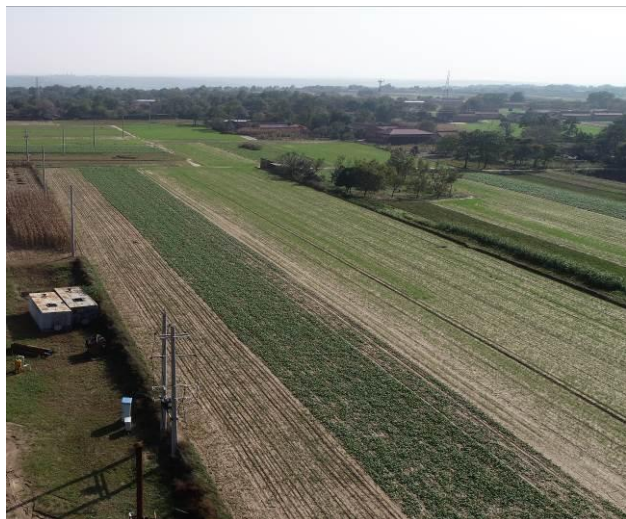
JH2P16 油井输变电线路
