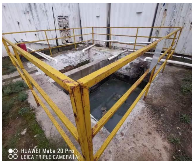
JH17P3 污水收集池
