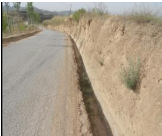
道路混凝土排水沟
