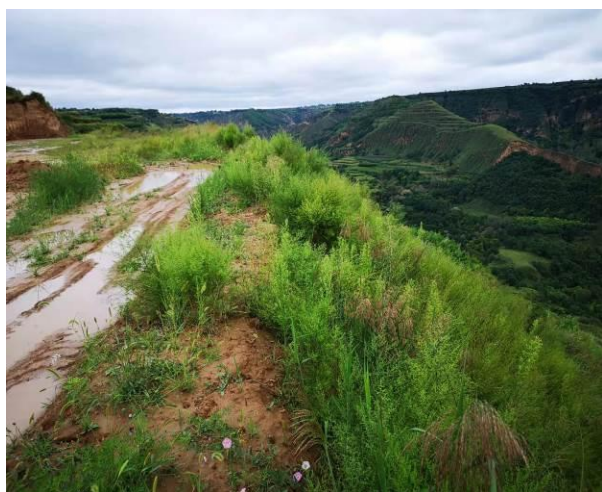
站场边坡植物护坡
