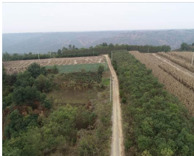
JH17P34 油井输变电线路
