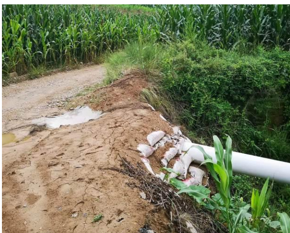
装填土袋道路护坡
