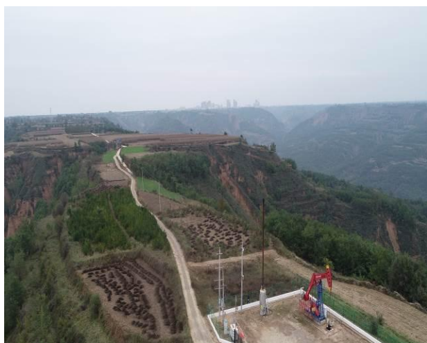
JH17P8 油井输变电线路
