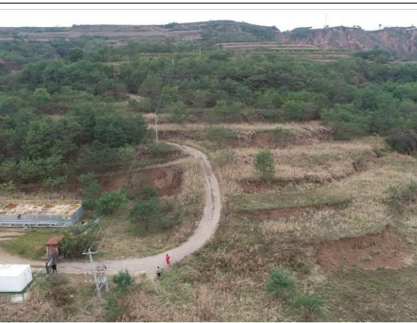
JH17P32 油井输变电线路
