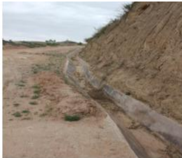
道路混凝土排水沟
