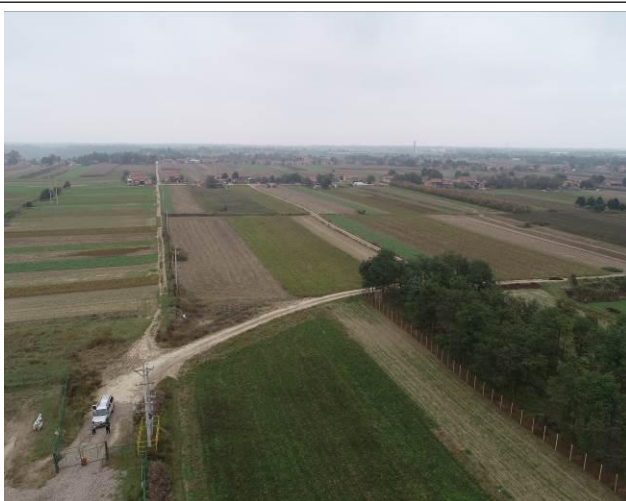
JH2P3 油井输变电线路
