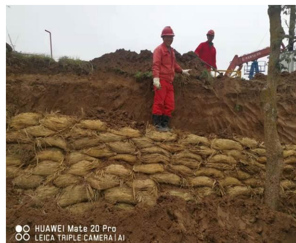
JH17P33 油井场边坡草袋护坡
