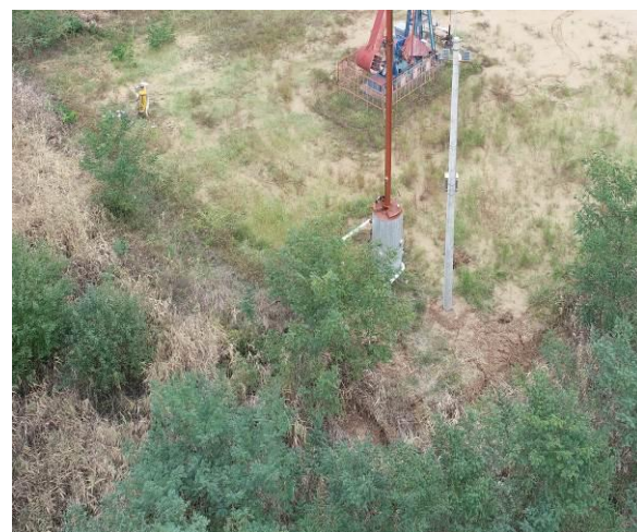
JH17P35 油井临时排水沟
