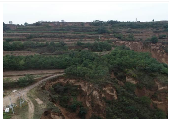
JH17P30 油井输变电线路
