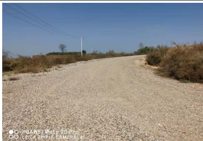
JH2P17 油井道路砾石压盖
