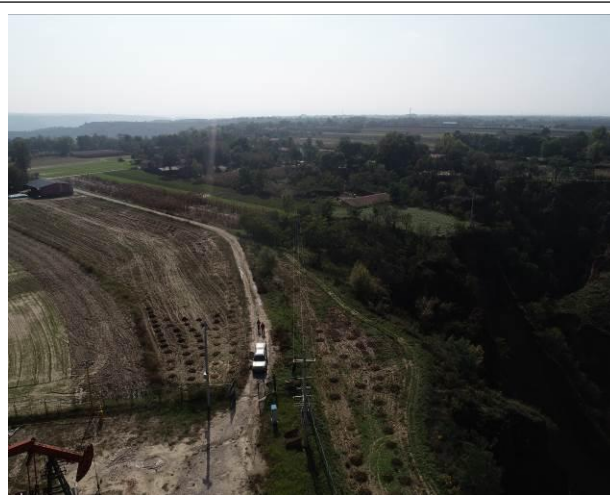
JH2P2 油井输变电线路
