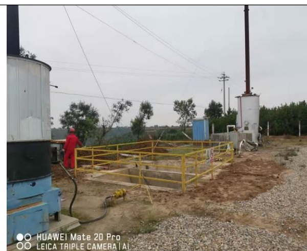
JH17P33 油井污水收集池
