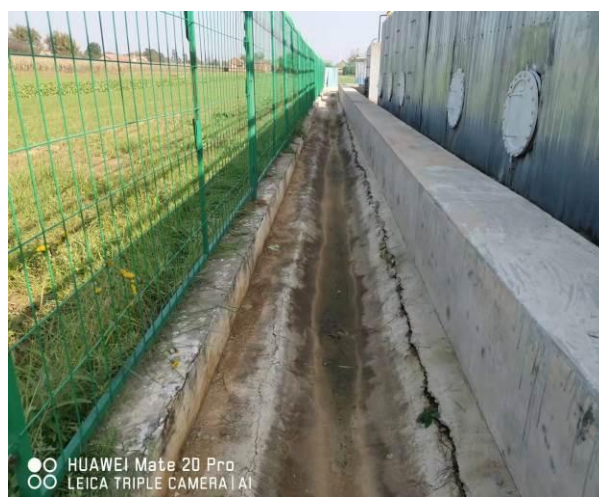
JH2P8 油井区排水沟
