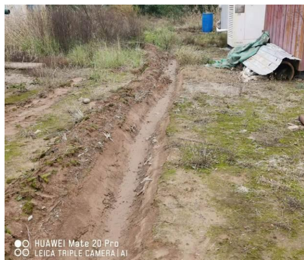
JH17P27 临时排水沟
