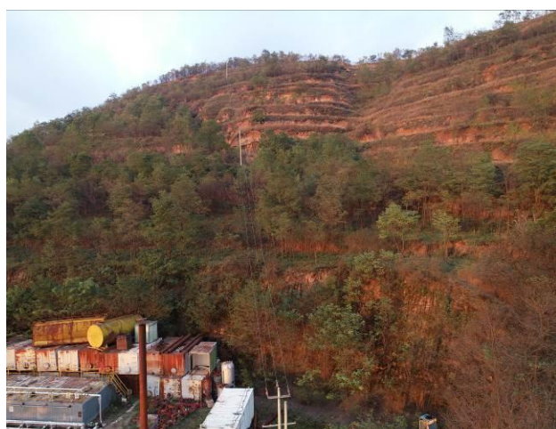
JH17P13 油井输变电线路
