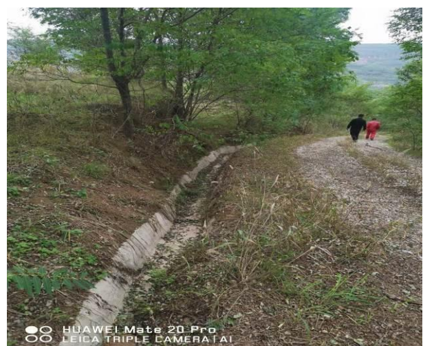
JH17P32 油井道路排水沟
