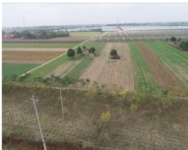
JH2P23 油井输变电线路
