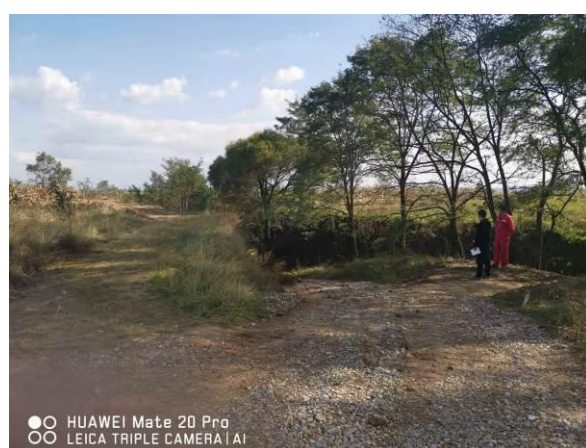
JH17P7 油井道路砾石压盖，植树绿化
