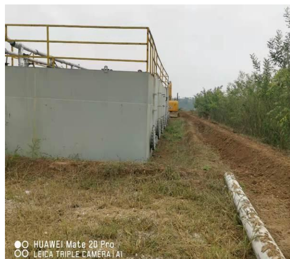
JH17P34 油井区临时排水沟
