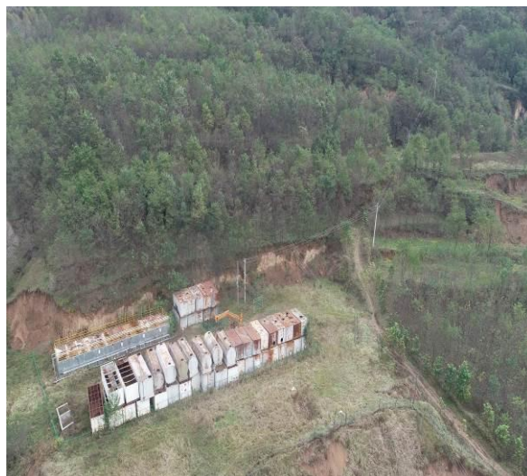
JHP4 油井输变电线路
