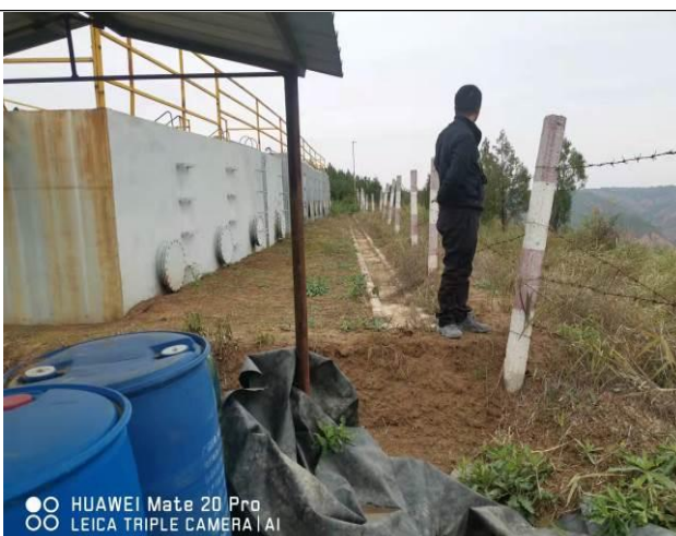
JH17P33 油井场区排水沟
