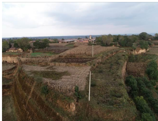
JH17P15 油井输变电线路
