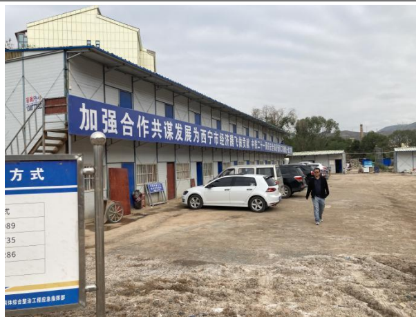
2022.6 施工生产生活区
