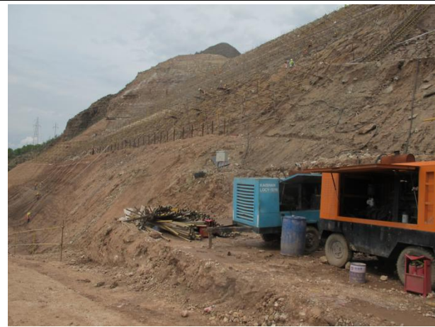
2021.7 三号隧道边坡
