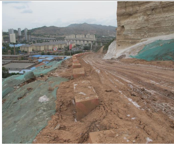
2021.7 道路区临时苫盖
