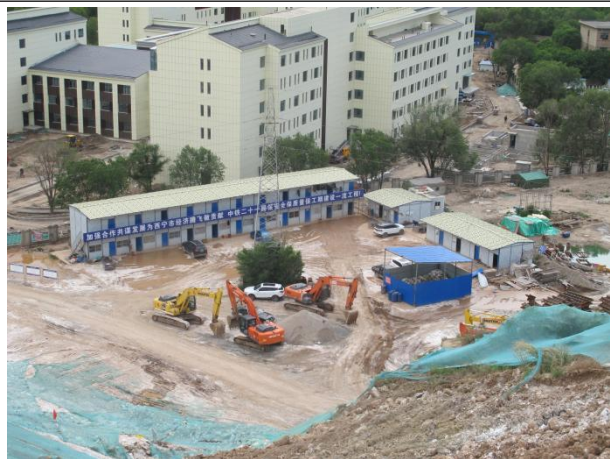
2021.7 施工生产生活区
