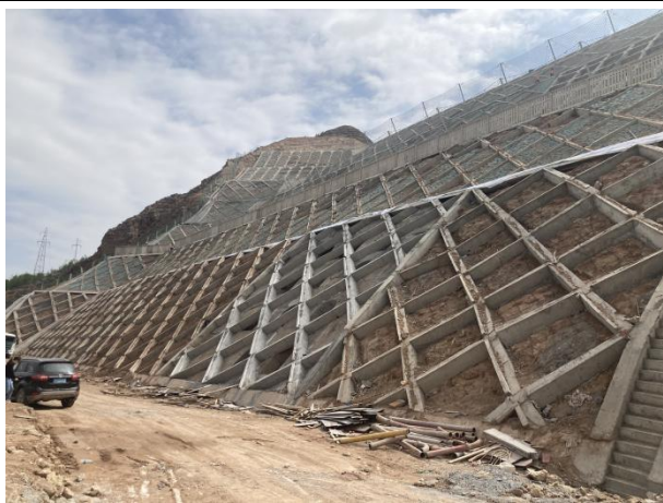
2022.6 三号隧道边坡
