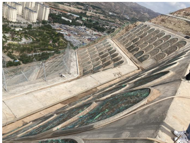
2022.6 三号隧道边坡
