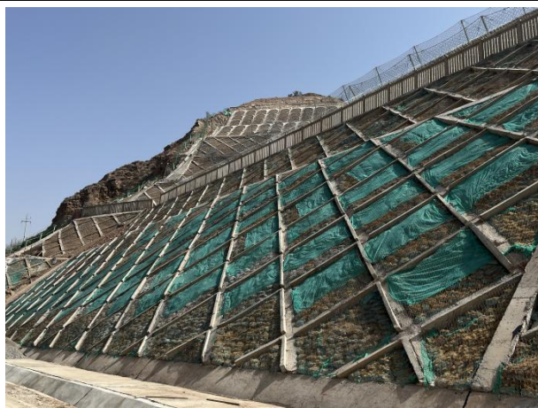
2023.4 三号隧道边坡
