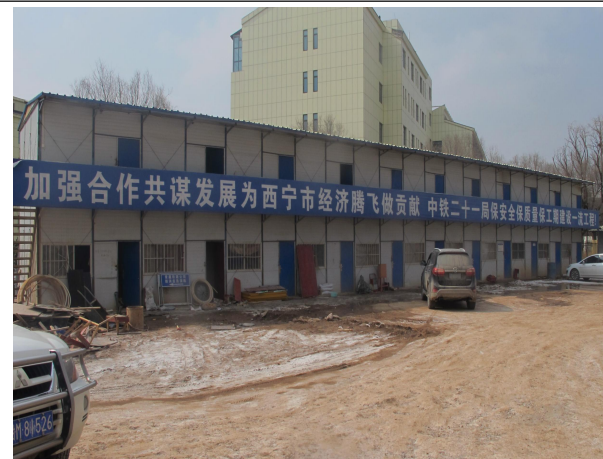
2023.2 施工生产生活区
