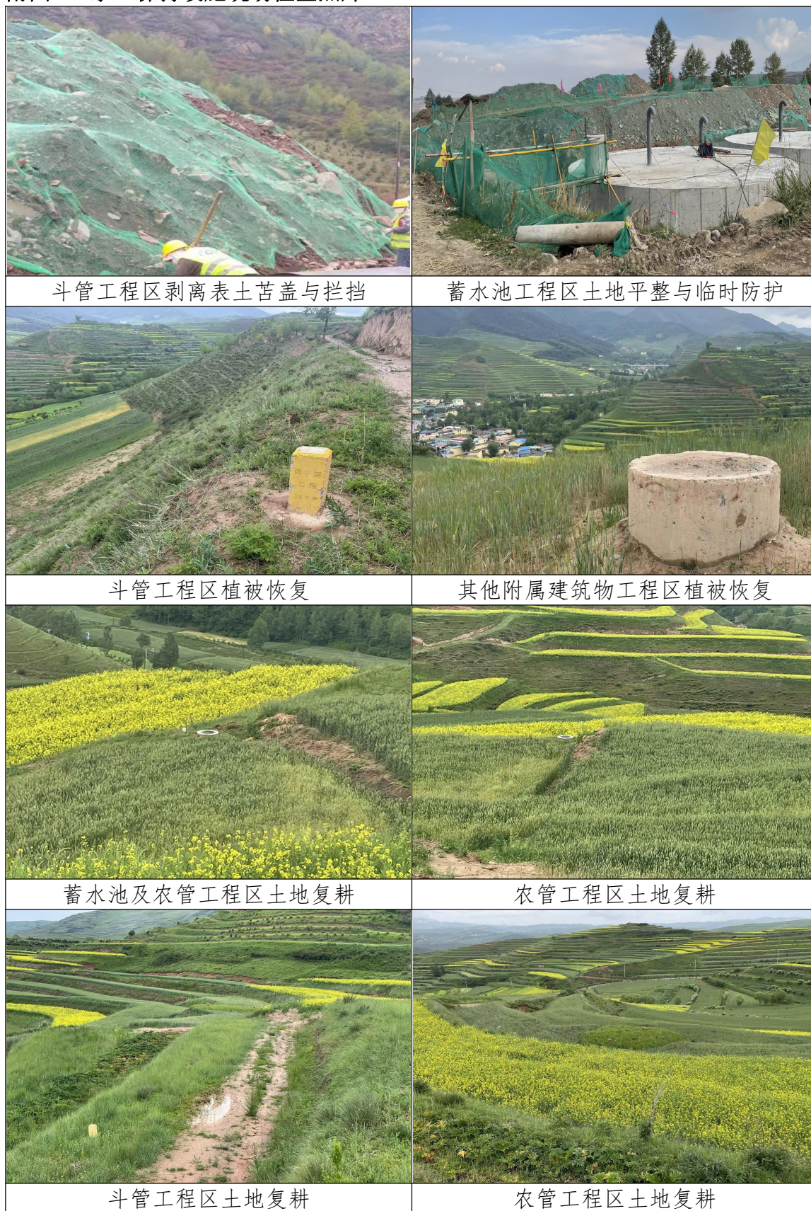
附图 1、水土保持设施现场检查照片
