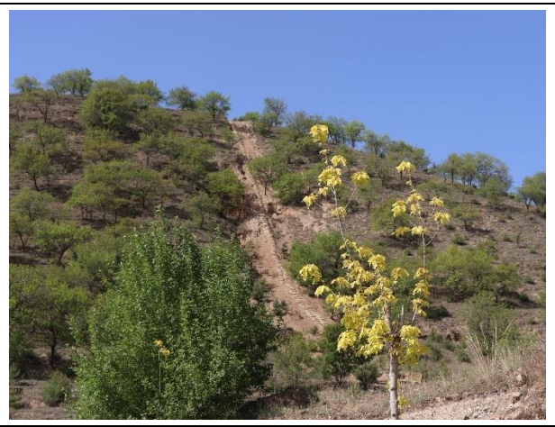
管线工程区草袋子护坡
