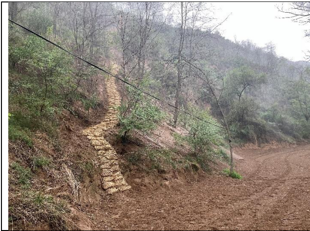
管线工程区草袋子护坡
