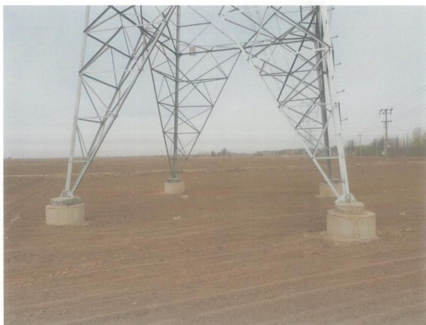
21#塔基区已恢复耕地
