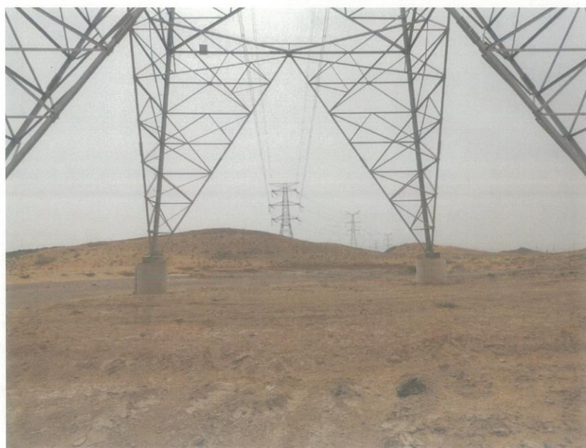
8号塔基区已恢复
