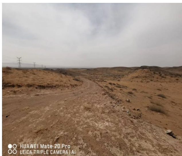
施工便道恢复现场
