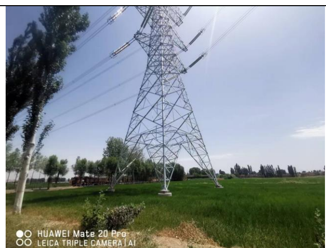
跨越乡村公路恢复现场
