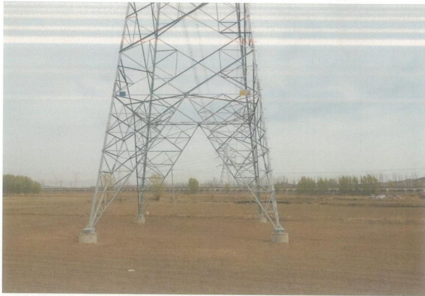
24#塔基已恢复耕地
