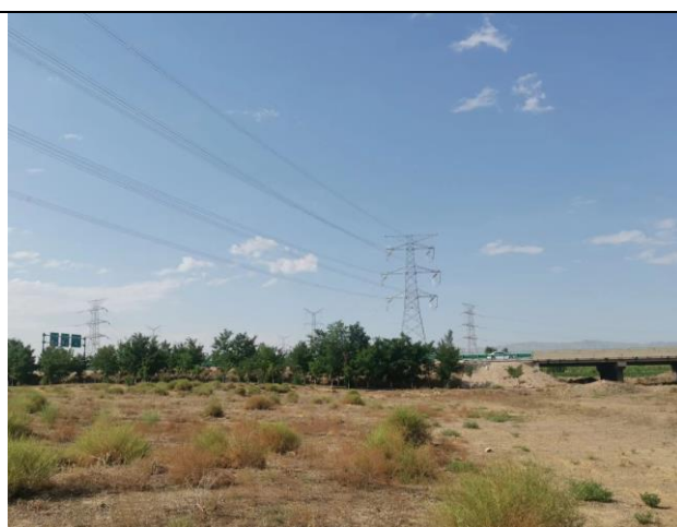
跨越高速公路恢复现场
