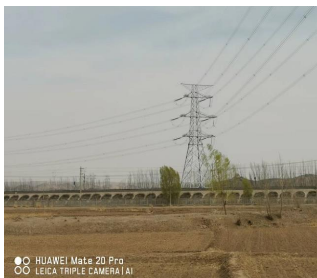
跨越铁路恢复现场
