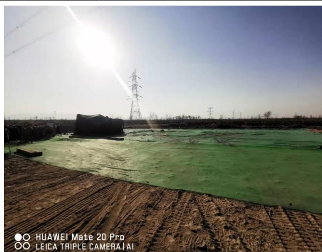
临时苫盖措施
