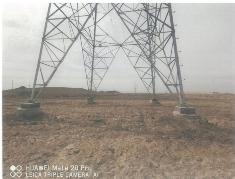
17号塔基已恢复
