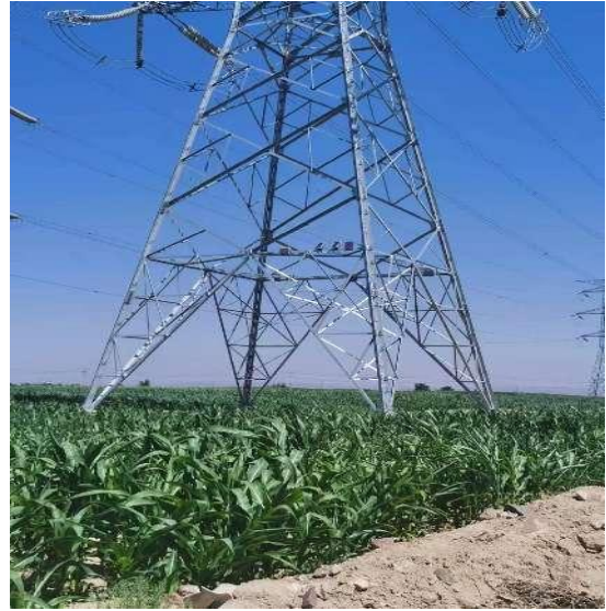
恢复耕地 (塔基及塔基施工区)
