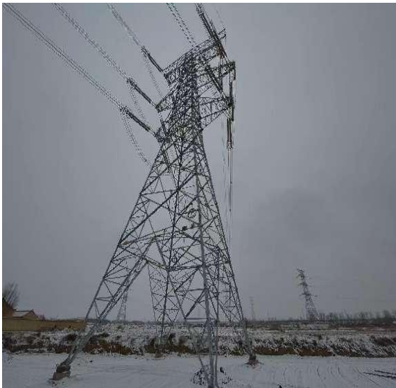
48#塔基 (塔基及塔基施工区)
