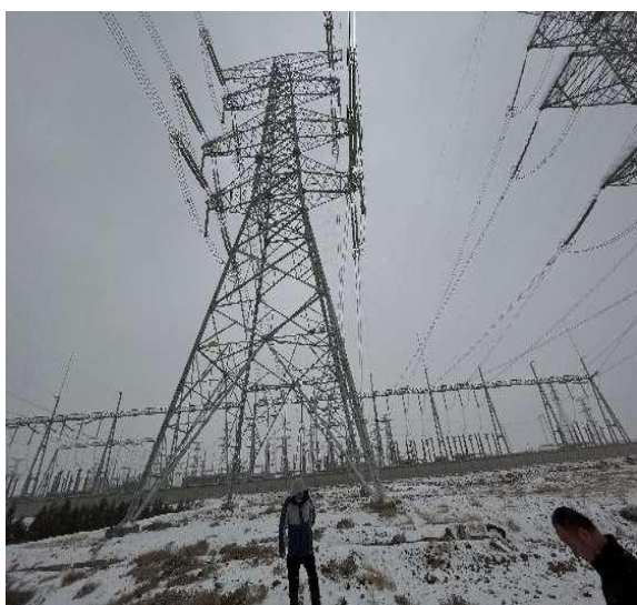
55#塔基 （塔基及塔基施工区）
