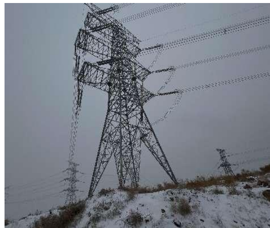
起点坡穆线 1#塔基连接到 原有三元中泰 20#塔基
