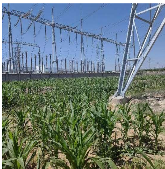
恢复耕地 （塔基及塔基施工区 55#塔基）
