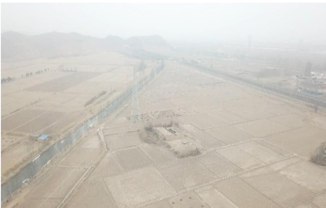
跨越施工区（跨越河道）（拍摄时间：2023年2月）
