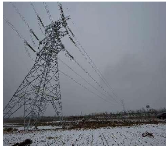
48#、47#塔基跨越定武高速 （跨越施工区）
