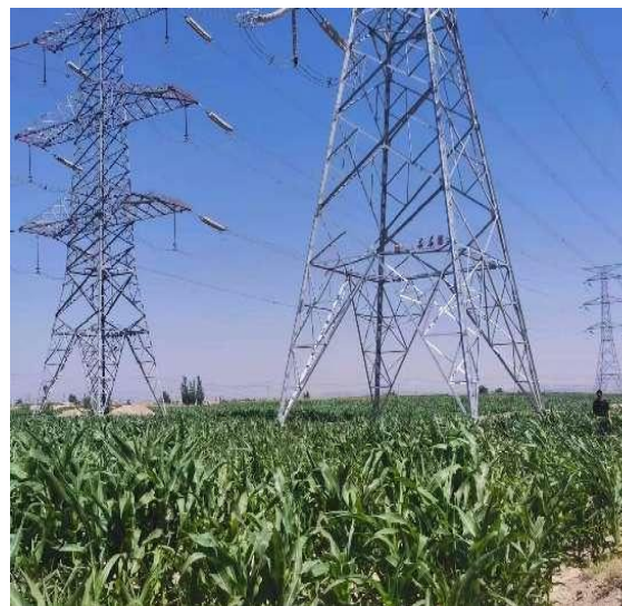
恢复耕地 (塔基及塔基施工区 48#塔基)
