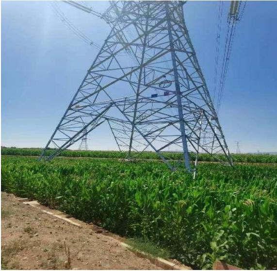
恢复耕地 (塔基及塔基施工区)
