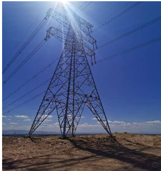
种草绿化 （塔基及塔基施工区 15#塔基）
