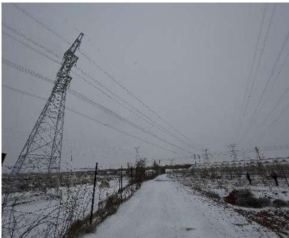
50#、51#塔基跨越包兰铁路 （跨越施工区）
