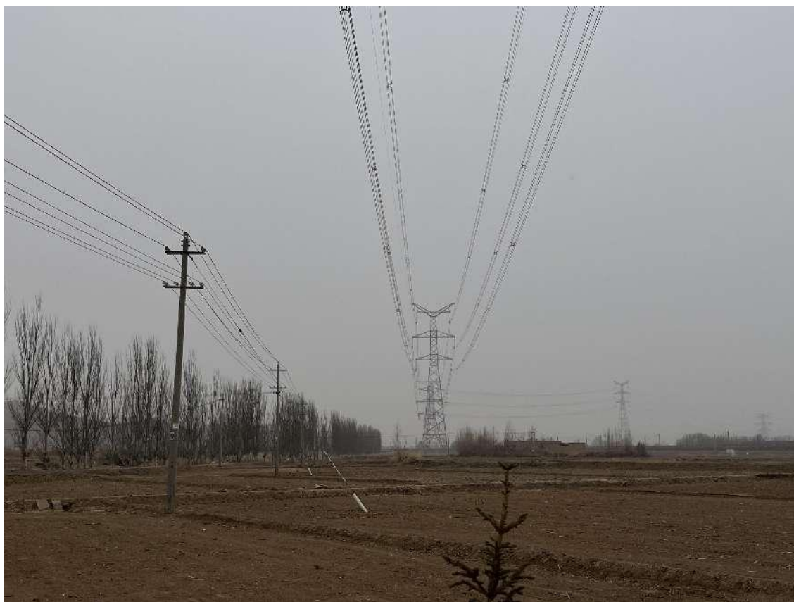
塔基及塔基施工区（拍摄时间：2023年2月）
