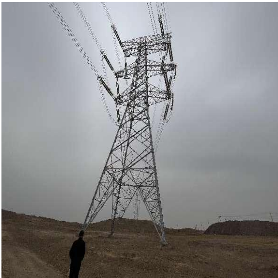
15#塔基 （塔基及塔基施工区）
