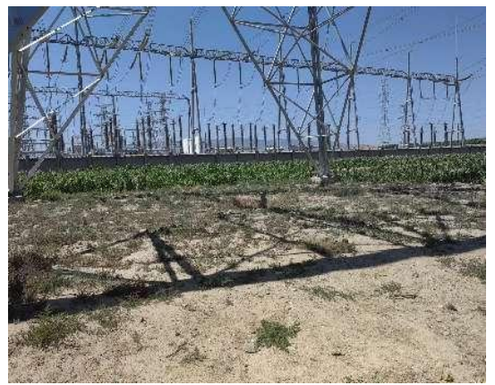
种草绿化 (塔基及塔基施工区)
