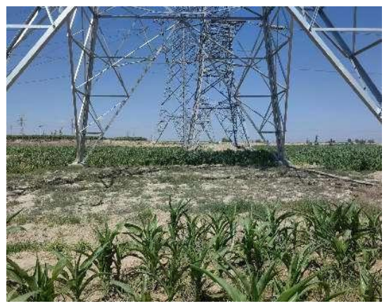
种草绿化 (塔基及塔基施工区)
