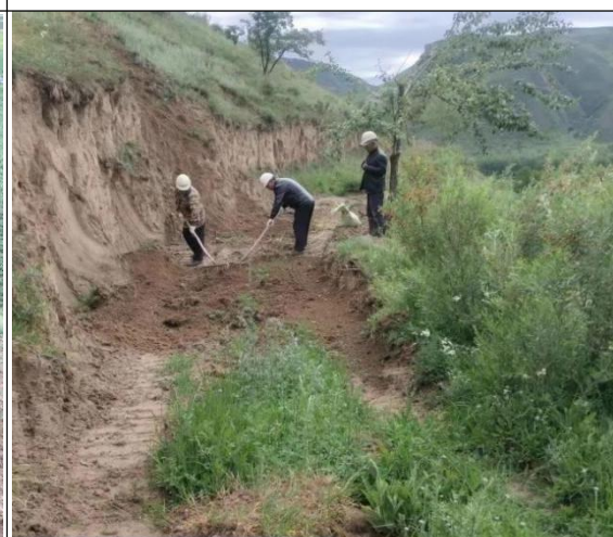
管线工程区场地平整及植被恢复
