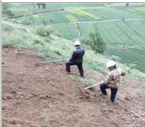
管线工程区场地平整及土地复耕
