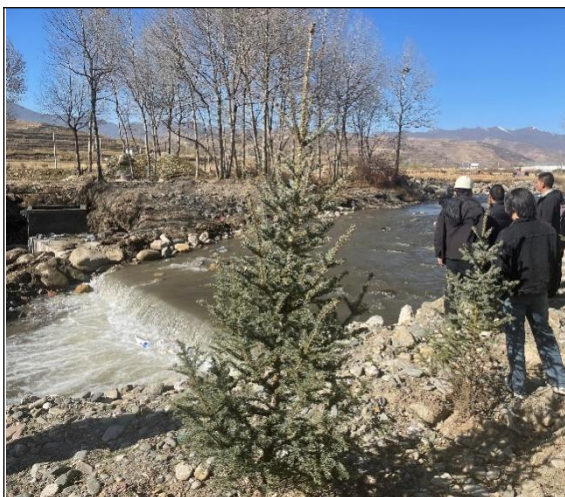
其他附属建筑物工程区植被恢复
