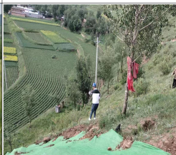
管线工程区土地复耕及植被恢复
