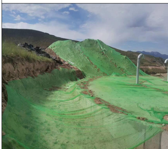
蓄水池工程区临时堆土苫盖
