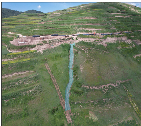
管线工程区植被恢复
