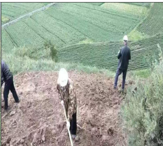
管线区场地平整及农地恢复
