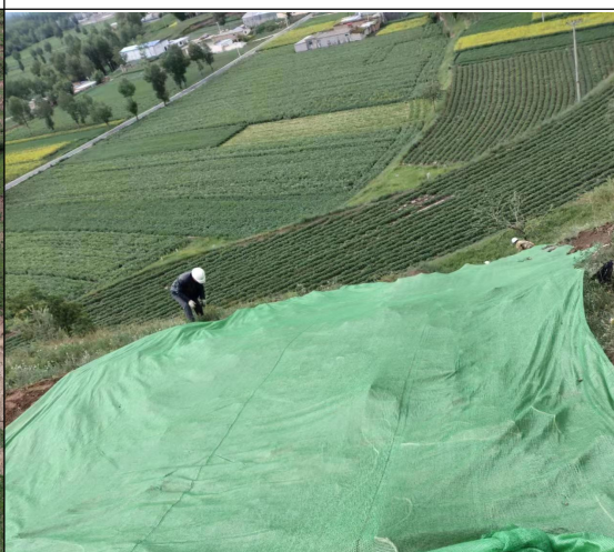
管线工程区农地恢复
