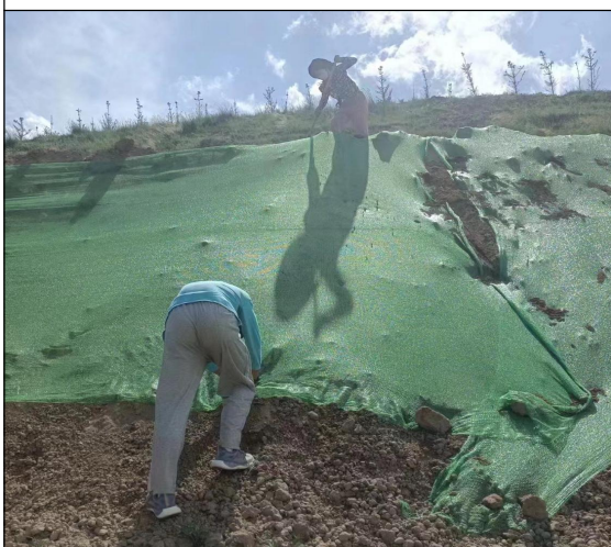
其他附属建筑物区临时堆土密目网苫盖
