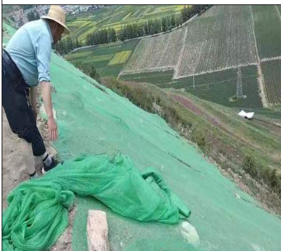
管线区临时堆土密目网苫盖
