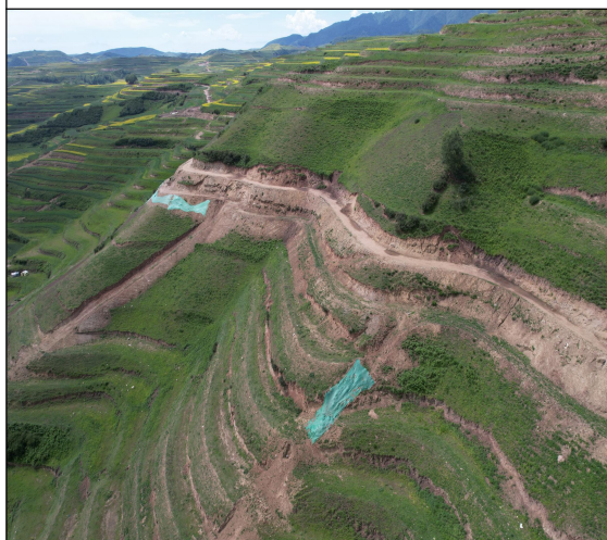
管线工程区植被恢复
